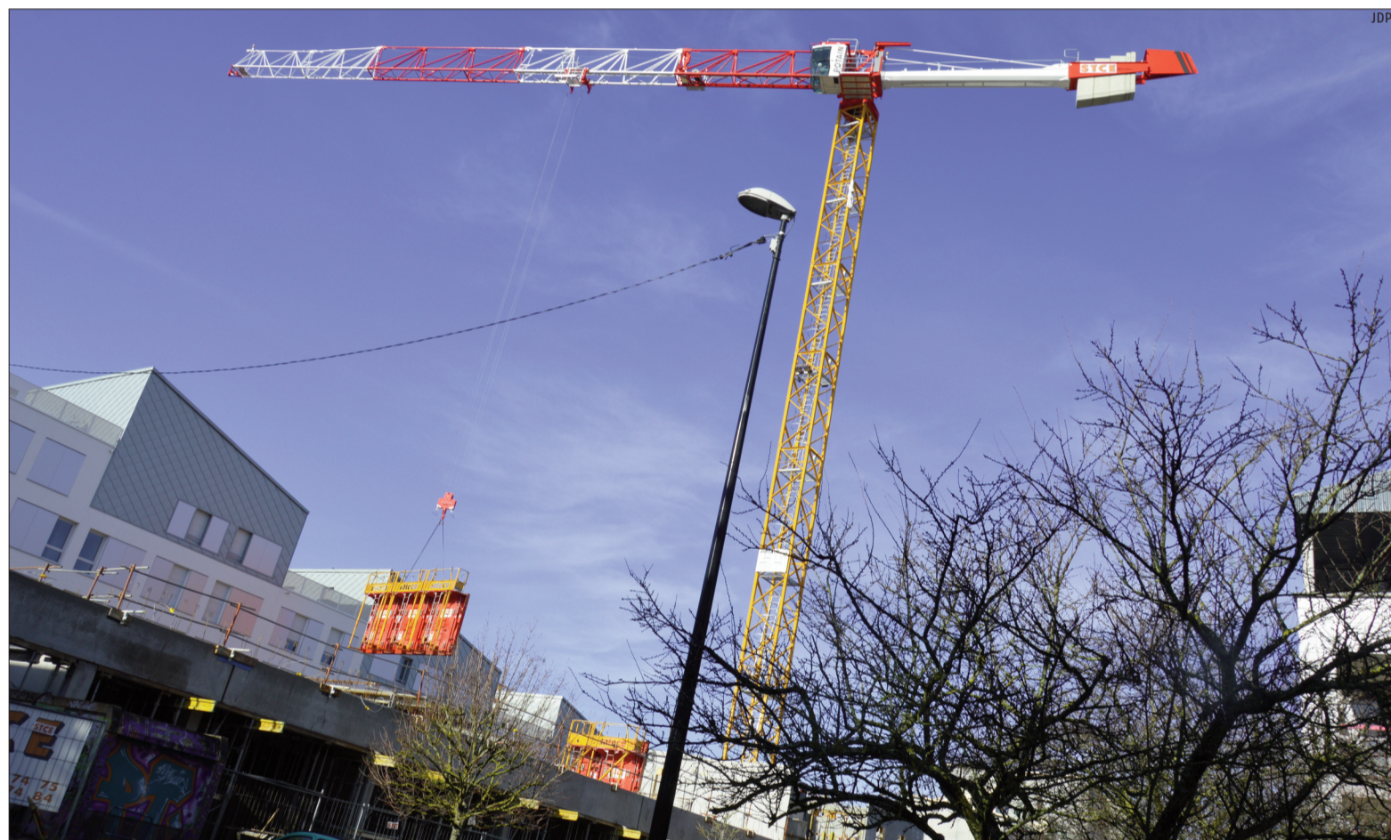
STCE est dirigée par Pascal Devroe depuis 2003. L'entreprise était née en 1981 sous le nom de Bordigoni. Elle est très impliquée dans la construction de logements collectifs (comme ici à Dijon, sur le futur écoquartier des Maraîchers). Elle vient aussi de poser la première pierre d'un hôtel Best Western, construit pour Icade Promotion, à Quetigny, près de Dijon.
